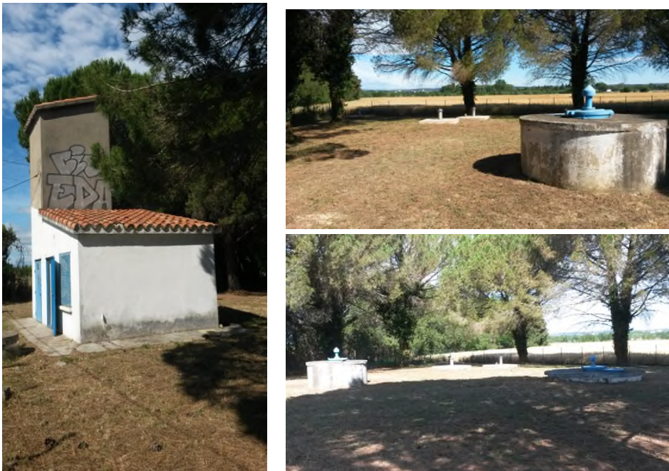
Photo 1 - Local technique, ancien puits, puits exploité et piézomètres sur le site du Puits des Canaux à BOUILLARGUES
